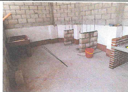
Foto 6: Construcción de gabinetes para cocina
