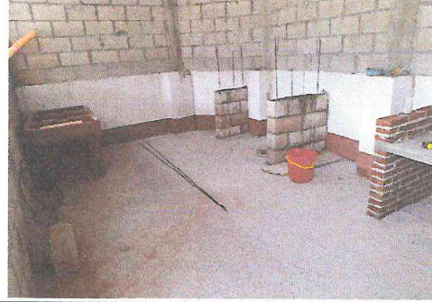
Foto 2: Instalación de cocina y sus implementos
