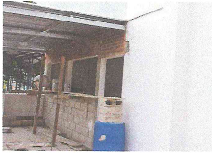
Foto 1: Reestructuración de cocina funcional
