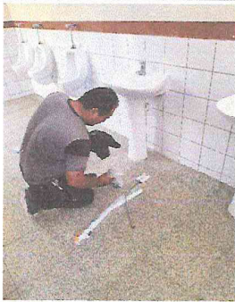
Foto 3: reparación de lavamanos
